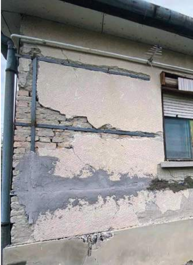
19. kép • Falsárok megkötésének kísérlete vaspántokkal, ami a kiváltó okok megszüntetése nélkül felesleges pénzkidobás. A kép sajnos rossz példa, így biztosan nem érdemes kivitelezni!
