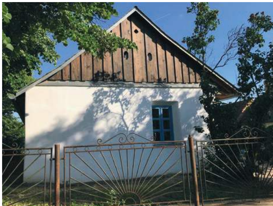
18. kép • Megsüllyedt az északi fal, amit szerkezetileg nem állítottunk helyre, de a homlokatzárást a felújítás során tompítottunk. Lovasberény, 2022
