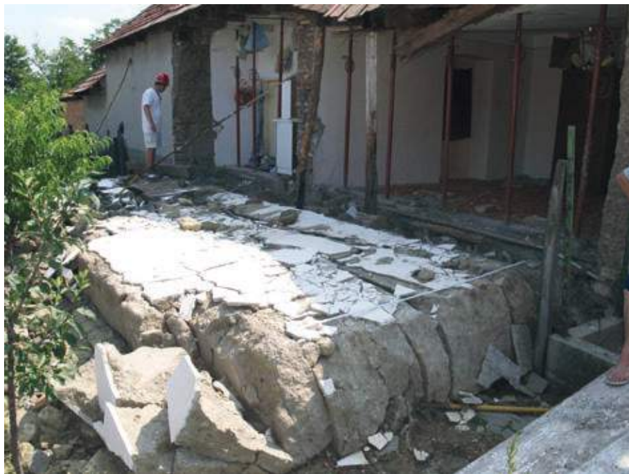
16. kép • Kidőlt a vert vályogfal, miután alig 20 cm homokos talajt egy ütemben kitermeltek a fal tövéből. Egy hatgyermekes család lett kis híján hajléktalan. A felújítást társadalmi munkában, több jó szándékú ember segítségével végezhettem. Mezőföld, 2014
