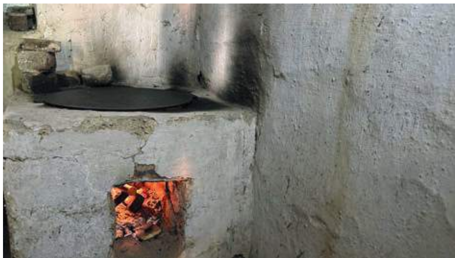
2. kép • Ég a tűz a katlanban, a szabadkéményes konyhában. A füst szabadon távozott, a hő pedig duplán hasznosult, mert nemcsak megfőtt az étel, de a helyiség is bemelegedett.
