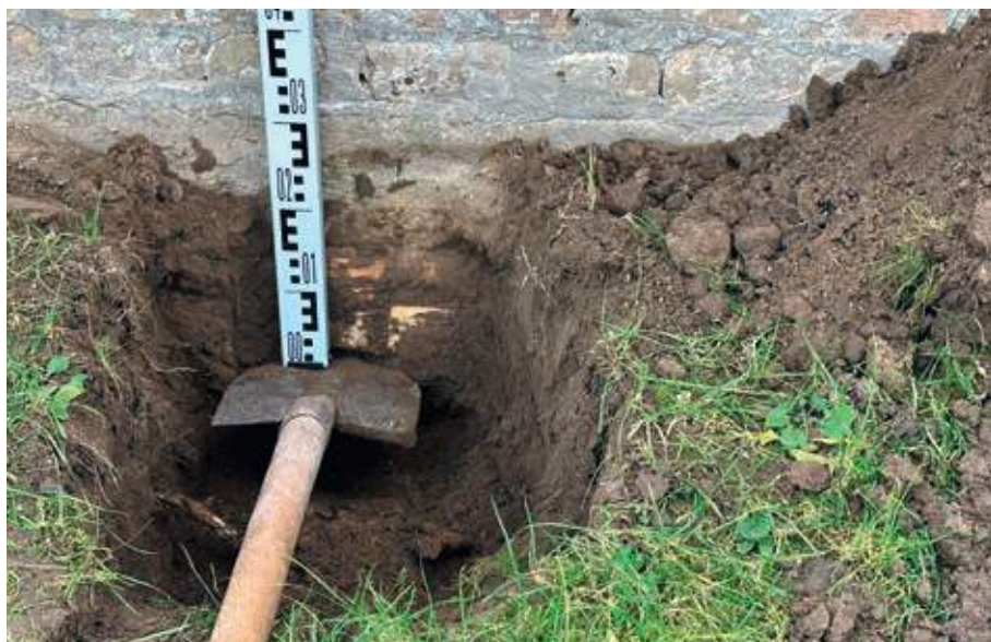
15. kép • Alapozási sík feltárása Sárszentlőrincen. A téglalábazat a terepsík alatt 25 cm-rel kezdődik. Ilyet ma már nem építünk, de ha működik, akkor miért ne maradhatna így? Természetesen a vizet jobban távol kell tartani majd az épülettől.
