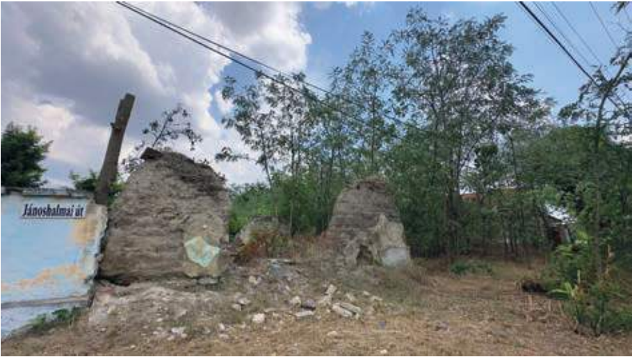
5. kép • Omladozó vályogház. Miután a tető megsemmisült, a falak is szétmosódnak.
