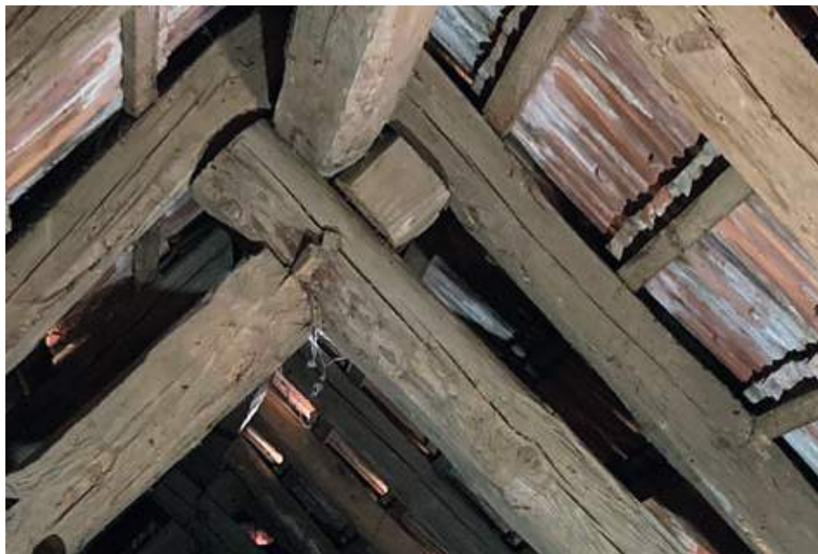
9. kép • Faszeggel kapcsolt székállás, fent a taréjszelemen és felette a szarufák. Dozmat, Vas vármegye, 2022
