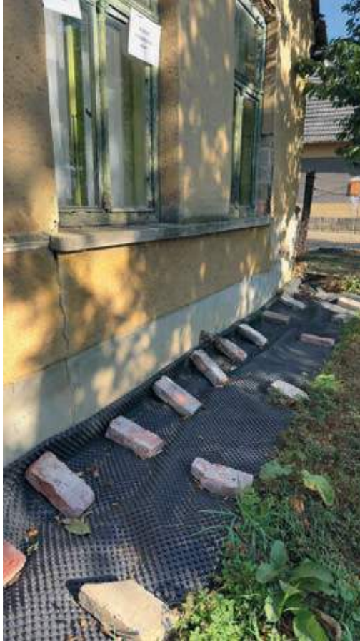
17. kép • A csapóeső rendre eláztatja az épület lábazata mentén a talajt. Ameddig a szakszerű drénezés el nem készül, addig is hasznos védeni az épület környezetét.
