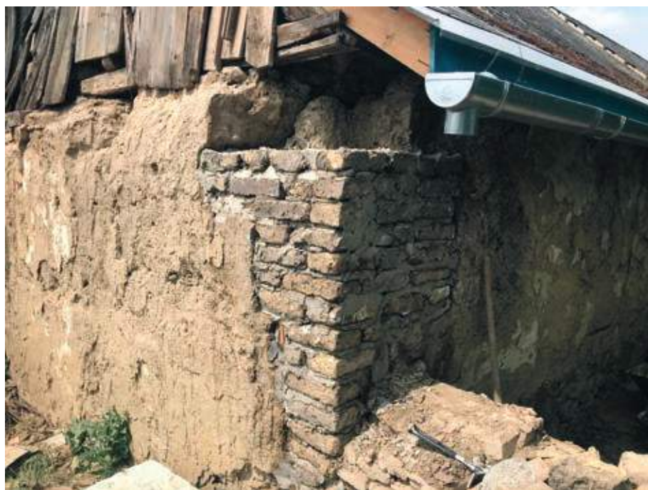
23. kép • Vályogtéglával javított vert fal. Az esőcsatorna hiánya miatt a falsarok valósággal elmállott. A tető és az ereszcsonna javítása után a falazatot javítottuk meg meszes habarcsba rakott vályogtéglával. Utóbb rájöttünk, a sárhabarcs is bőven elég lett volna. 200 éves ház, Lovasberény, 2020
